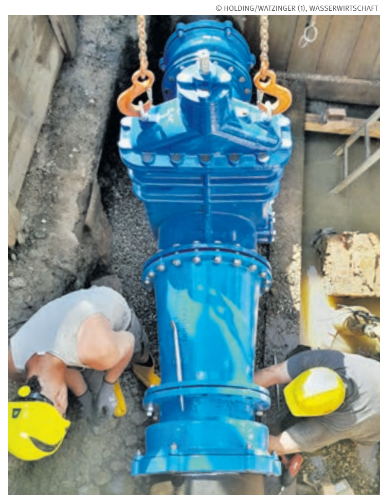
▲ Wasserleitungen. Im Zuge der Gleissanierung wurden in der Körösistraße neue Schieber eingebaut.
