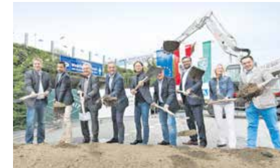
Gemeinsam. StR Mario Eustacchio (4. v. l.) glücklich beim Spatenstich.
