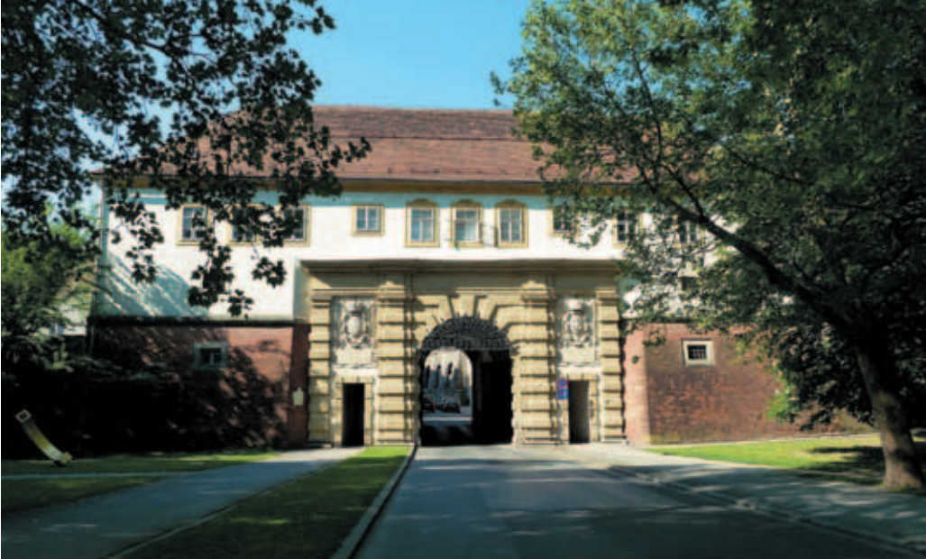
Abb. 23 Äußeres Paulustor vom Stadtpark
