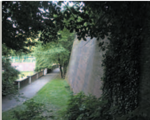
Abb. 45 Nördliche Befestigungsmauer beim Paulustor
