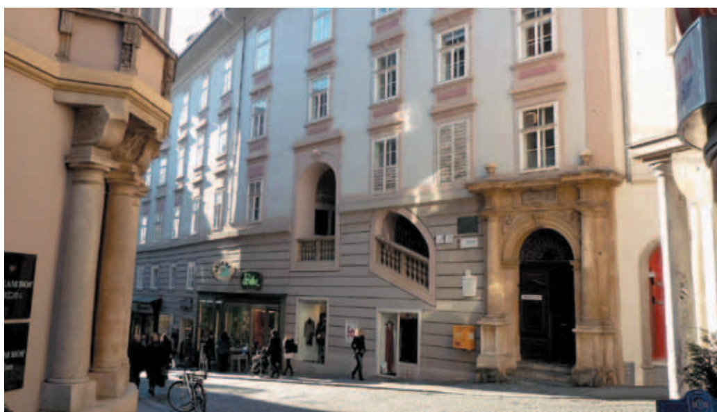
Abb. 14 Sporgasse, Aufgang zur Stiegenkirche
