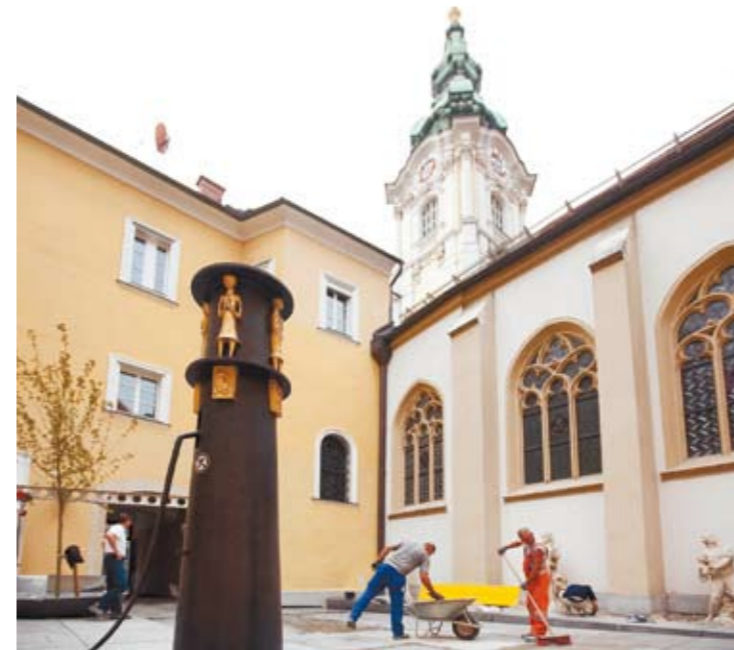
Bei der Renovierung des Stadtpfarrhofes wird letzte Hand angelegt.
